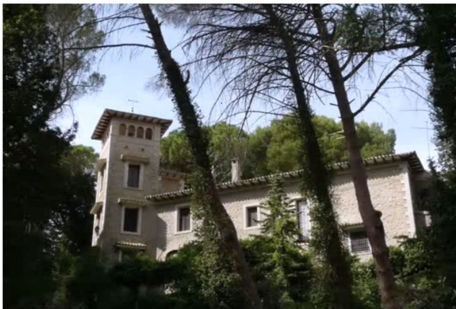
Imagen actual del edificio principal de la Cueva de la Potita (fotografía de Ana Guerrero).
